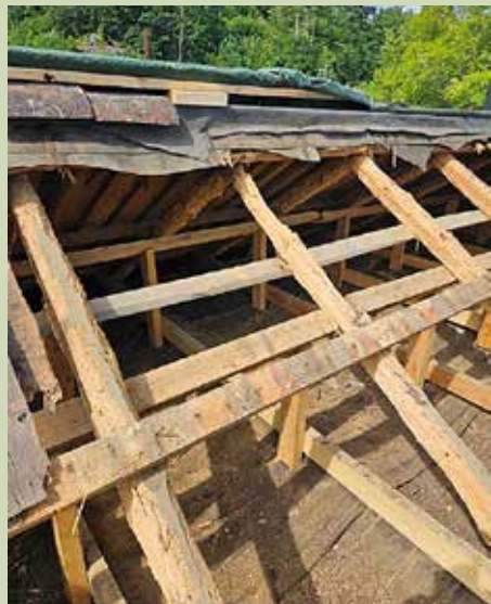
Råteskader i tak og vegger.
