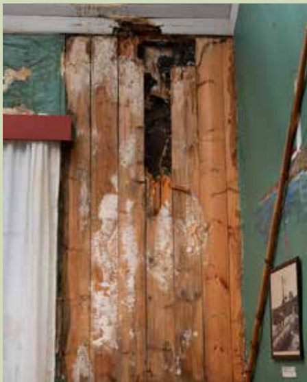
Råteskader i tak og vegger.
